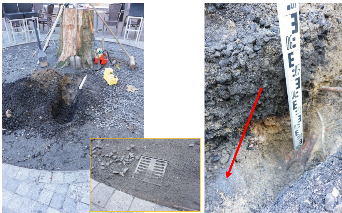
Foto 4 en 5: Beeld van profielkuil bij de stobbe van de gewone plataan met boomnummer 1909673 (links) en detailfoto van de opbouw (rechts). De rode pijl geeft de ligging van Geotextiel weer.
